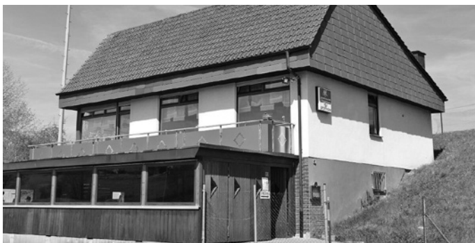
Fassaden- und Anbausanierung stehen beim TSF Vereinsheim an.
