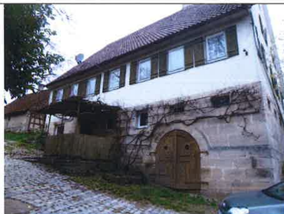
Wohnhaus, mit Sandsteinsockel und altem Gewölbekeller der eine Höhe von ca. 8m hat
